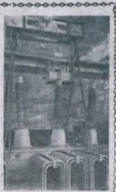
Запорожский трансформаторный завод закончил сборку первого силового трансформатора типа ТДНГ 40500-132 для Идли. Мощность трансформатора 40500 киловольтагер.
