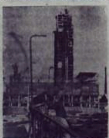
ЧЕЧКО-ВИГУШКАЯ АССР. В Грозном завершается строительство установки непрерывного контактного коксования (Г-18). На этой установке из тяжёлых крекинг-остатков битума и нефти будет производиться бензин, дизельное топливо и электрический кокс.
