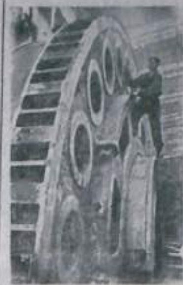
ЛЕНИНГРАД. На металлургическом заводе идет изготовление гребней гидравлической турбины для ударной стройки семилетки — Братской ГЭС. Эта машина мощностью 225 тысяч киловатт является крупнейшей в мире. Диаметр рабочего колеса ее составляет 5,5 метра и весит 120 тонн.
