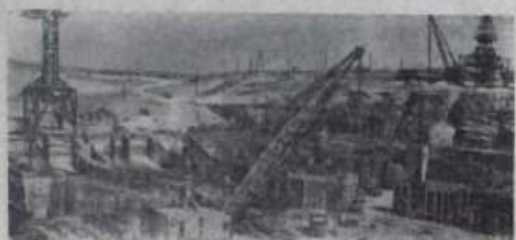
КИРГИЗСКАЯ ССР. На крупнейшей стройке республики — Уч-Курганской ГЭС — с опережением графика идет строительство основных гидросооружений.
