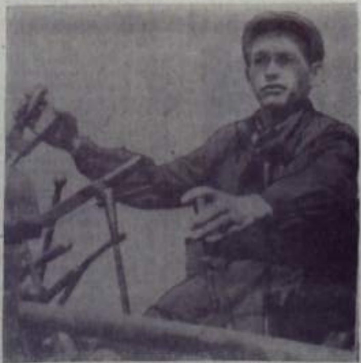
Ежедневно задолго до смены Нагим Каримов проводит осмотр своего трубоукладчика. Поэтому и работает он безотказно.
