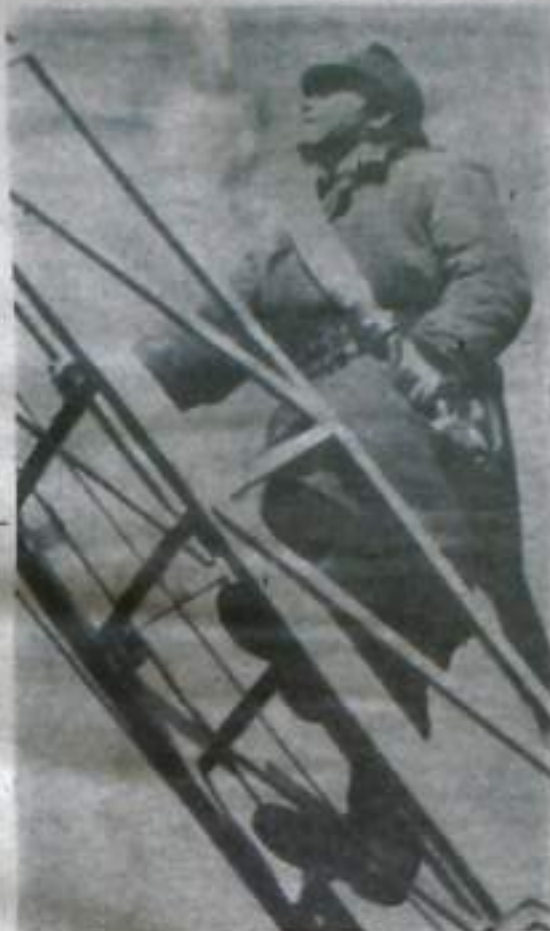
На вооружении центральной пожарной части имеются автоматические механические лестницы, с помощью которых бойцы в течение 1 минуты поднимаются на высоту до 20 метров.
