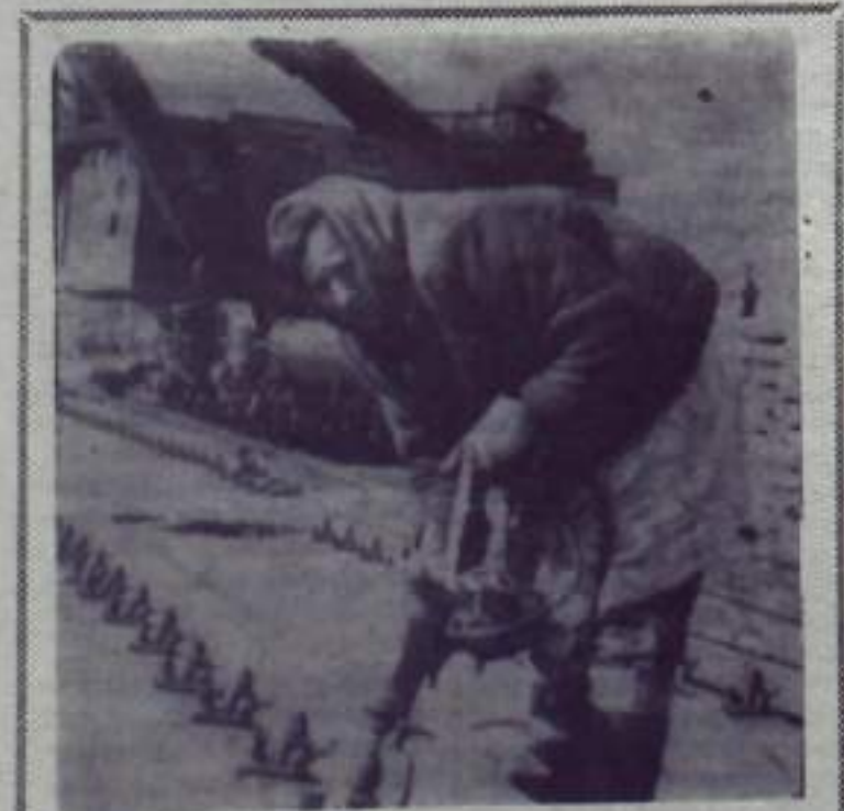
Более 17 лет работает в погрузочно-транспортном управлении комбината «Башкируголь» рабочая пути Е. Г. Стюкова, и трудится она вечно, добросовестно, со знанием дела. На этом снимке запечатлен момент, когда Е. Г. Стюкова трудится на сборке звеньев железнодорожного пути на железобетонных шпалах в день юбилейного субботника 12 апреля с. г.
