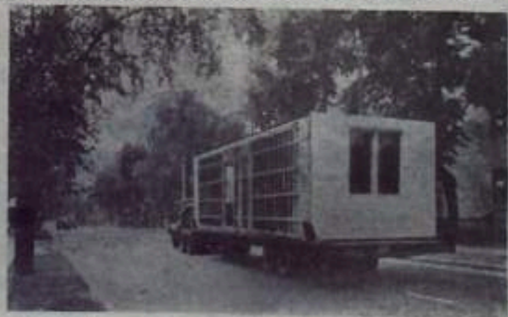
Москва. На столичном заводе железобетонных изделий №6 начато производство объемных элементов для строительства жилых домов, в том числе целых блок-квартир из которых будут собираться жилые дома. Первое такое здание будет скоро собираться в 113-м квартале Новых Кузьминок.
