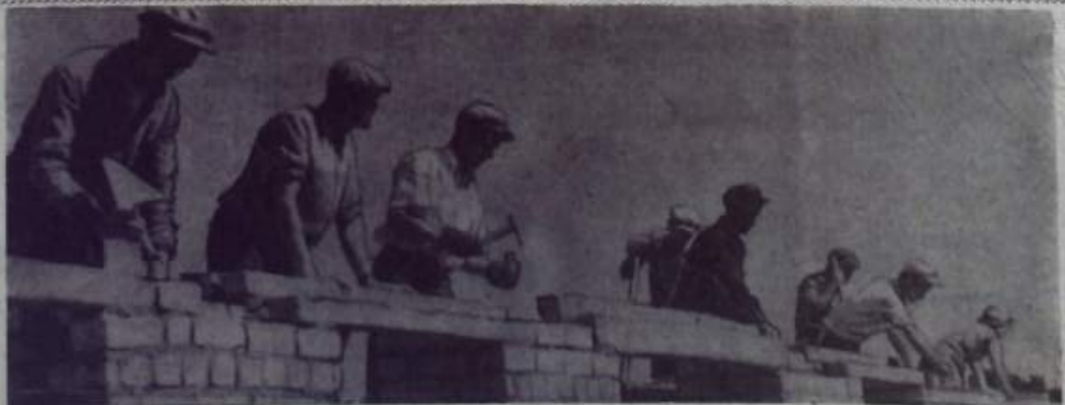
Этот снимок сделан накануне. Для строители в новом микрорайоне города — квартале 39—40. На фотографии вы видите бригаду З. Янбердина на кладке дома № 30. Руками строителей этой бригады в новом районе сооружен не один дом. Сейчас там трудятся строители-отделочники.
