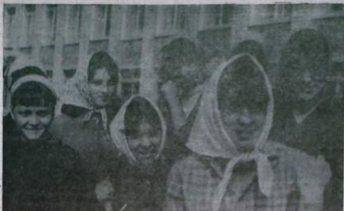
Кривой Рог. Будет новая школа в микрорайоне. Сейчас внутри здания ведутся отделочные работы. На лесных пролетах и эстаках трудятся монтажники, электрики, штукатуры, столяры.
