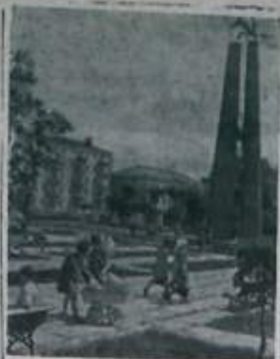
ЛУГАНСКАЯ ОБЛАСТЬ. Благоустроивается горняцкий город Кировск. Вырастают новые кварталы жилых домов, сооружаются школы, кинотеатры, магазины.
