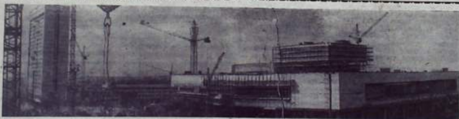
УЛЫАНОВСК. Издалека видно теперь эти два строения на берегу Волги — Ленинский мемориальный центр и гостиницу «Венец», сооружаемые на родине вождя.
