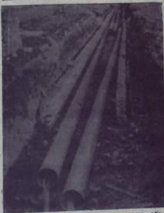
Второе строительное управление треста «Кумертаустрой» ведет строительство крайне важного для города объекта — теплотрассы по ул. Ленина. Не будет она введена в строй до наступления отопительного сезона — половина трасса остается без тепла. Сейчас в процессе строительства пока лишь первая половина трассы. Однако строители почему-то не очень торопятся. Последние дни людей на объекте не видно. Наш снимок — он сделан в 9 часов 5 минут утра — подтверждает это.
