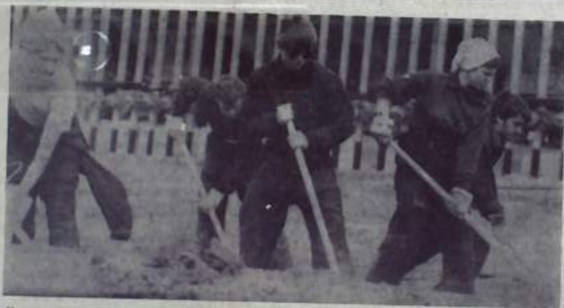
Четвертая бригада отряда «Икар» ведет строительство монолитной дороги.
