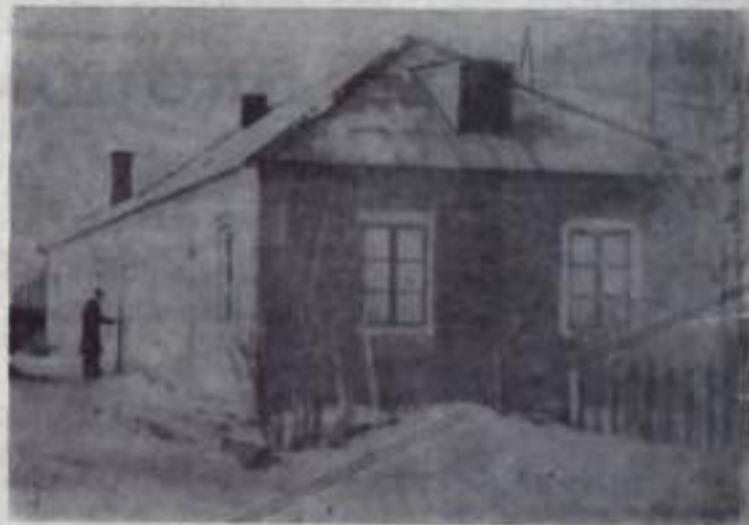
На снимке: общий вид новой постройки.
