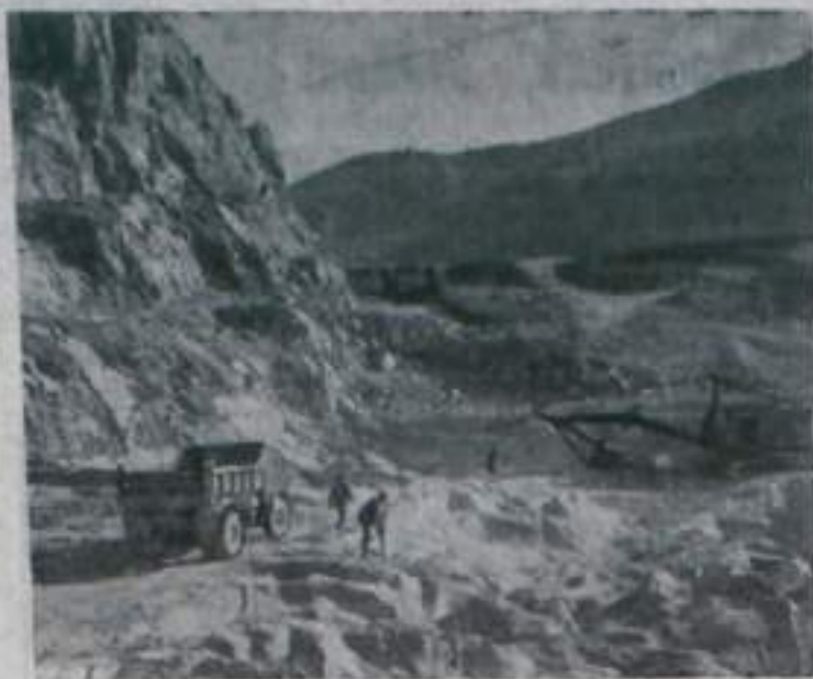
На снимке: общий вид строительства водохранилища.
