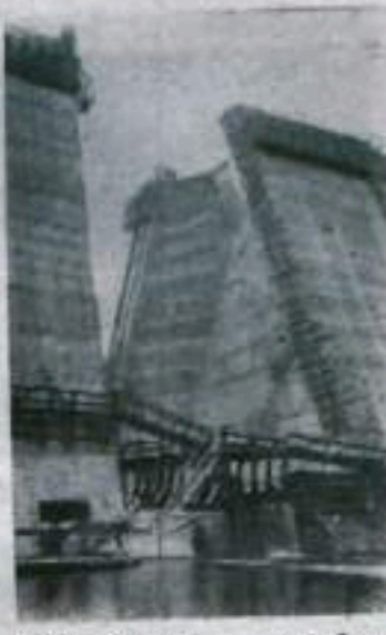
Чехословацкая республика. Строительство Флайской плотины. Она будет состоять из 33 блоков. Ее высота достигнет 50 метров. Фото Б. Крейчи. Чехословацкое телеграфное агентство.
