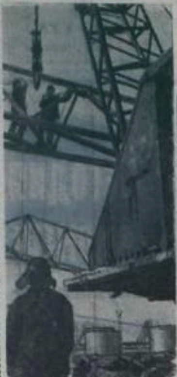
КУМЫШЕВСКАЯ ОБЛАСТЬ. В городе Новокумьшевском строится вторая очередь завода синтетического спирта. Здесь будет вырабатываться сырье для получения каучука на сооружаемом в Ставрополе-на-Волге заводе синтетического каучука. На снимке: монтаж сваренного порталного крана на строительстве завода синтетического спирта. Фото А. Бранова. Фотография ТАСС.
