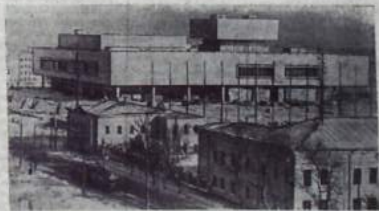
УЛЬЯНОВСК. Ближе к завершению строительство Ленинской мемориальной зоны. Ударно трудятся в эти дни коллектив треста № 1, возводящий объекты величественного памятника вождю пролетариата.
