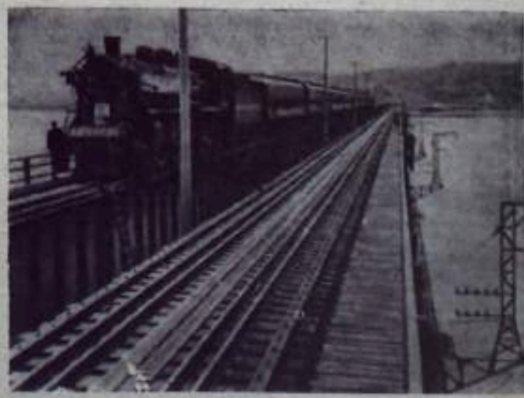
Китайская Народная Республика. Закончено строительство самого длинного в стране железнодорожного моста через реку Хуанхэ в провинции Хэнань. Строительство велось по проекту китайских инженеров.
