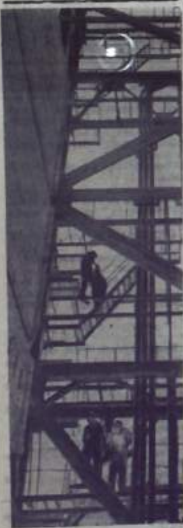
В энергосистему Узбекистана дал промышленный ток третий турбогенератор Ташкентской ГРЭС. Мощность его — 150 тысяч киловатт.
