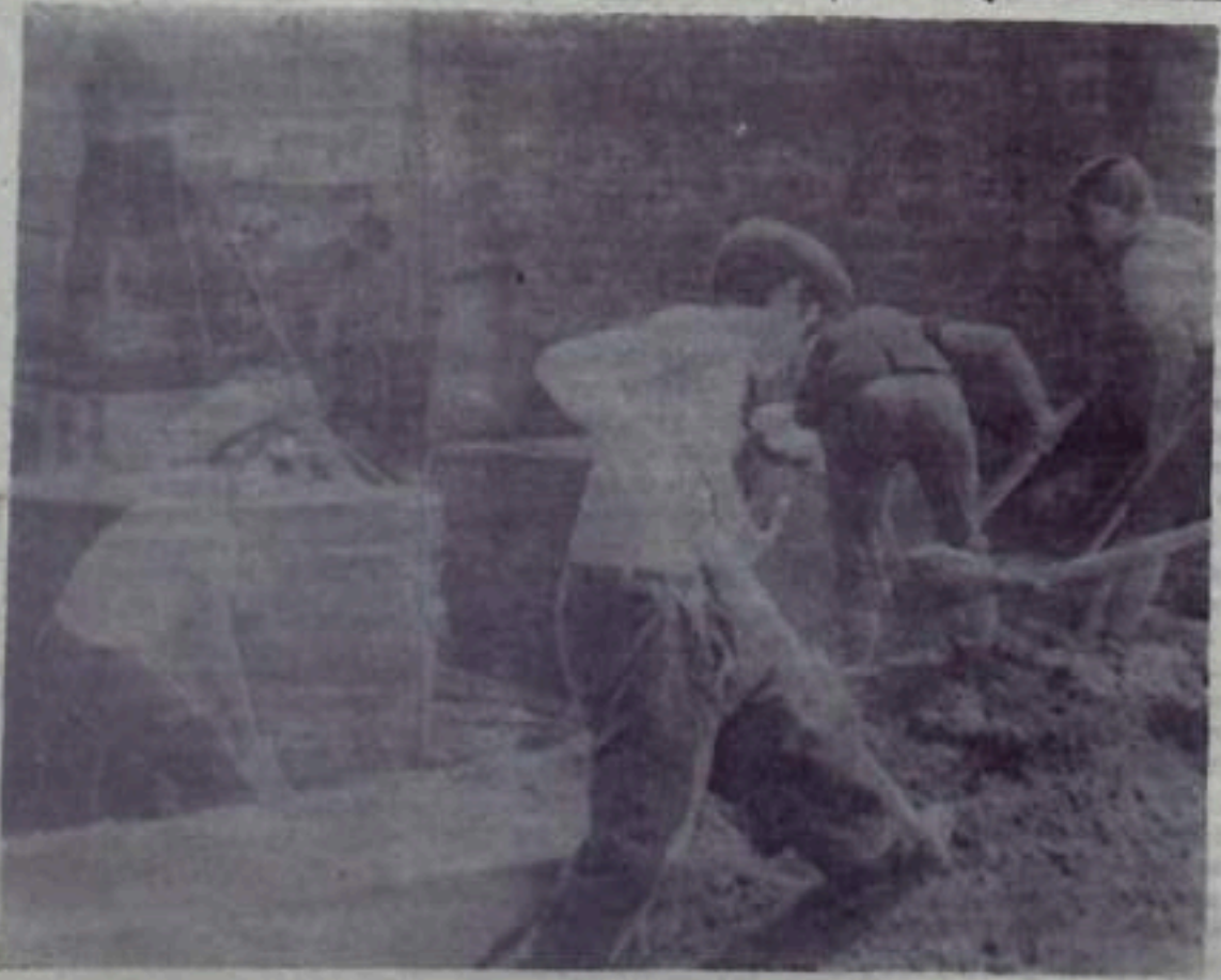
На снимке: бригада студентов из отряда «Ударник» на строительстве подземного газохранилища.
