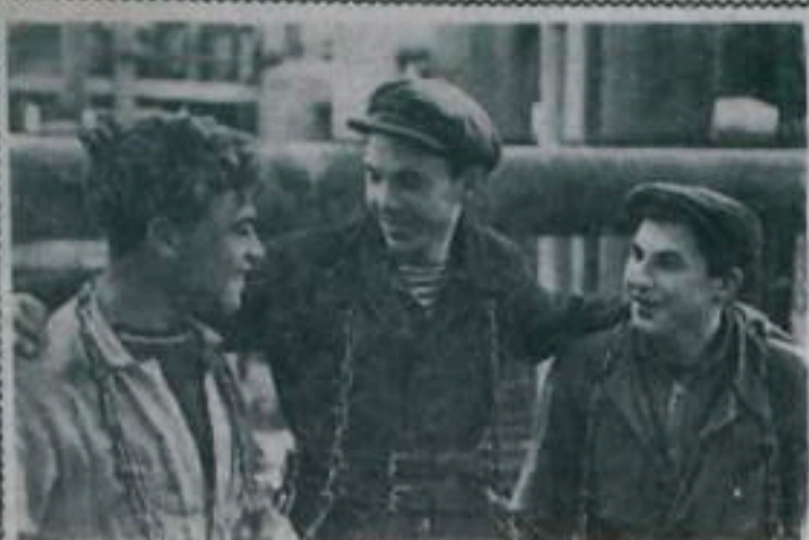
САРАТОВСКАЯ ОБЛАСТЬ. Сварщики Балковского саратовского завода вступили в предсвадебный период. Стрижки решали к середине июля нынешнего года закончить монтаж оборудования и стали возводить конструкции. Тем самым уже в этом году будет обеспечена переработка саратовской свалки нового урожая. Среди передовиков стройки выделяется бригада монтажников-сварщиков, руководи-
