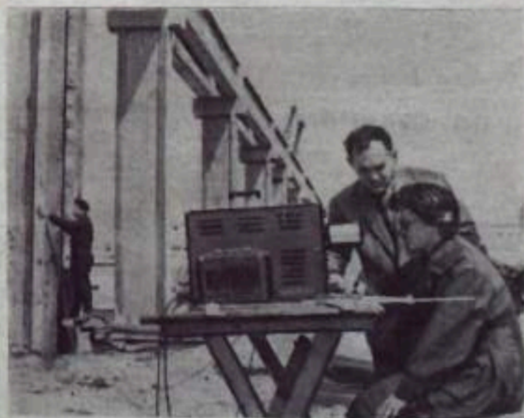
КВБВ. В научно-исследовательском институте строительства и архитектуры Украинской ССР создана оригинальная установка для испытания бетона. Ее автор—инженер С. И. Позин. Эта установка является своеобразной «скалой» технической помощи. Шумный прибор передает в толщу бетона ультразвуковые волны, при помощи которых определяется прочность материала, его однородность, внутренние дефекты—расслоения, трещины. Ультразвуковые измерения можно производить в конструкциях толщиной от 5 сантиметров до 10 метров.
