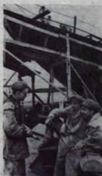
НИКОЛАЕВ. На стенах завода имени В. И. Ленина студенты Никольского кораблестроительского института сооружают большую парусно-моторную лодку (объемом 30 тонн). Они сами спроектировали лодку в своем конструкторском бюро. По слеме, составленной студентами, электрические механизмы будут выбирать якоря и подтягивать лодку при швартовке.
