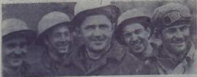
КЕМЕРОВСКАЯ ОБЛАСТЬ. Отлично работает на монтаже замкового стана Залыба бригада имени XIII съезда КПСС треста «Сибсталконструкция», руководимая Михаилом Рабцом.
