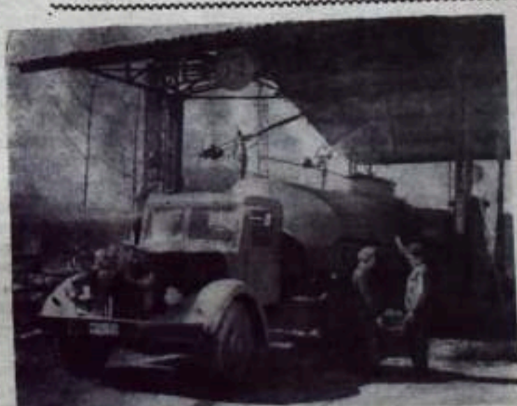
МОСКВА. На Вышинской нефтебазе вступила в строй разработанная конструкторским бюро среднего автомата и телеметрии нефтяной и газовой промышленности система автоматического плавца автоцистерн. Управление системой и дозирование отпущаемых нефтепродуктов производится с диспетчерского пункта. При этом автоматически печатаются документы, в которых указывается наименование и отпущенное количество нефтепродуктов, и также дата отпуска. Применение этой системы не требует обслуживающего персонала (за исключением диспетчеров). На снимке: автоматический плавца нефтепродуктов в автоцистернах. Фото В. Гаганова. Фотохроника ТАСС.
