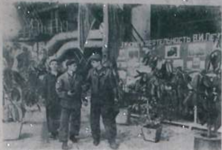
На Краснодарской ТЭЦ одним из лучших производственных коллективов является комсомольско-молодежная бригада слесарей, возглавляемая Павлом Аллибриди. Она ремонтирует сложное оборудование теплоэлектростанции. В этой бригаде все учаща: одни в техникуме, другие в институте, только самый молодой Владимир Положарчук — в восьмом классе средней школы. Все посещают университет культуры. Бригада завоевала звание коммунистической. В летнем лагере, где она работает, четыре бригады получили это высокое звание. Три переодически Красным знаменем украшают этот передовой цех, обставленный цветами, стендами и картинками.
