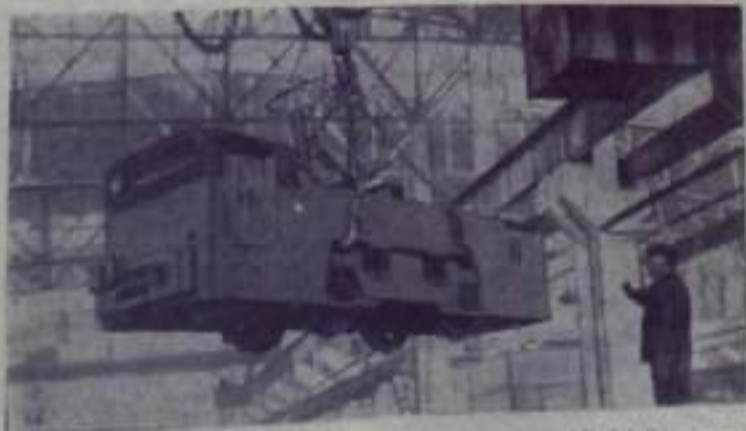
Периская область. Новый шахтный электровоз ИК 14-3 разработан и изготовлен на Александровском машиностроительном заводе. Первые опытные образцы этой серии уже проходят испытания на угольных шахтах и рудниках страны.
