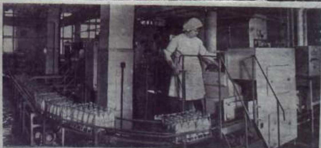
Приморский край. До 150 тонн молока может переработать в сутки недавно введенный в строй завод в Уссурийске. Он выпускает продукцию двадцати наименований. На снимке: цех розлива молока в бутылки. На переднем плане — оператор А. И. Борисенко.
