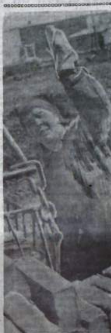
Г. Рахматуллина в ПМК-325 треста «Кумертаустрой» работает такелажницей. Она очень серьезно относится к своей нелегкой профессии. Строители благодарны ей за четкую подачу кирпича, растворов и другого строительного материала.
