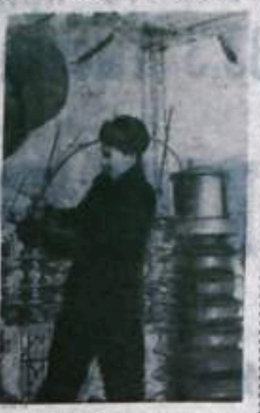
На снимке: слесарь Клайпедской электросети И. Дабашинкас готовит полосу подстанции на 110 киловольт на линии, соединяющей Клайпедскую теплоэлектростанцию с Калининградской энергетической системой.
