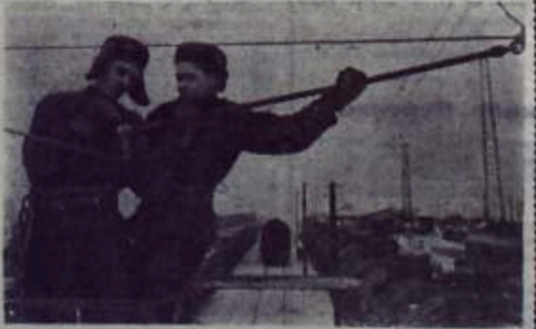
МОРДОВСКАЯ АССР. Быстро электрифицируется железнодорожная магистраль, связывающая Москву с Иркутском. На участке дороги, проходящей по территории республики, широким фронтом развернулся монтаж линии электропередачи, монтажники линии и оборудование главной подстанции. Больших трудовых успехов здесь добиваются рабочие
