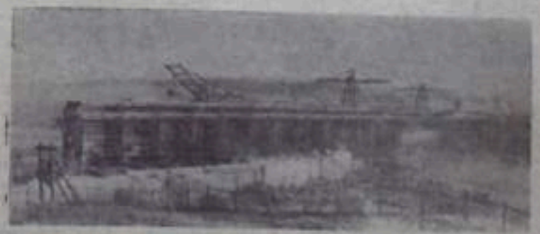
Строительство Братской ГЭС. Вид с мыса Пурсей.
