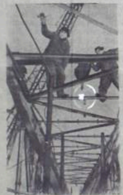
Строители треста «Камчатстрой» возводят в Петропавловске-Камчатском домопостроительный комбинат, рассчитанный на производство 35 тысяч квадратных метров жилой площади в год.
