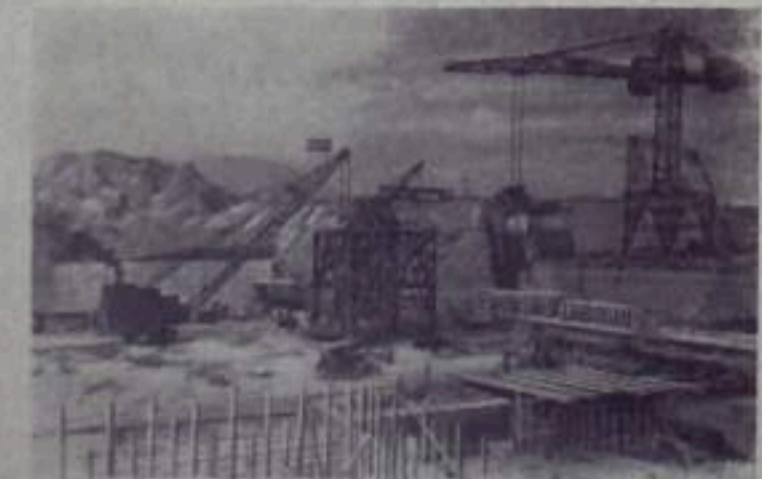
Таджикская ССР. Строители одной из крупнейших в Средней Азии Головной ГЭС отказались от сооружения дорогостоящей бетонной эстакады. Вместо нее решено установить два 25-тонных башенных крана. Это намного удешевит и сократит сроки строительства.
