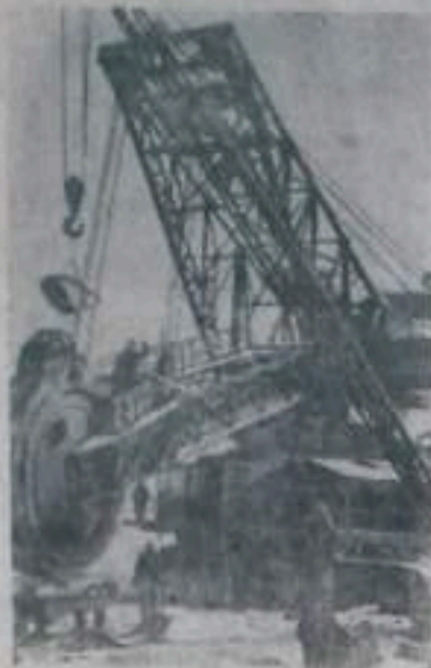
Украинская ССР. В Александровском буроголомном бассейне Кировоградской области закончено строительство еще одного мощного разреза — Балаховского. Он будет давать востора миллиона тонн топлива в год. Все процессы добычи угля, вскрыши и транспортирование пород будут полностью механизированы и автоматизированы. Сейчас здесь монтируют транспортноотвальный мост и роторные экскаваторы. На снимке: монтаж роторного экскаватора «РС-350» на Балаховском углеразрезе. Фото Г. Верушкина. Фотохроника ТАСС.
