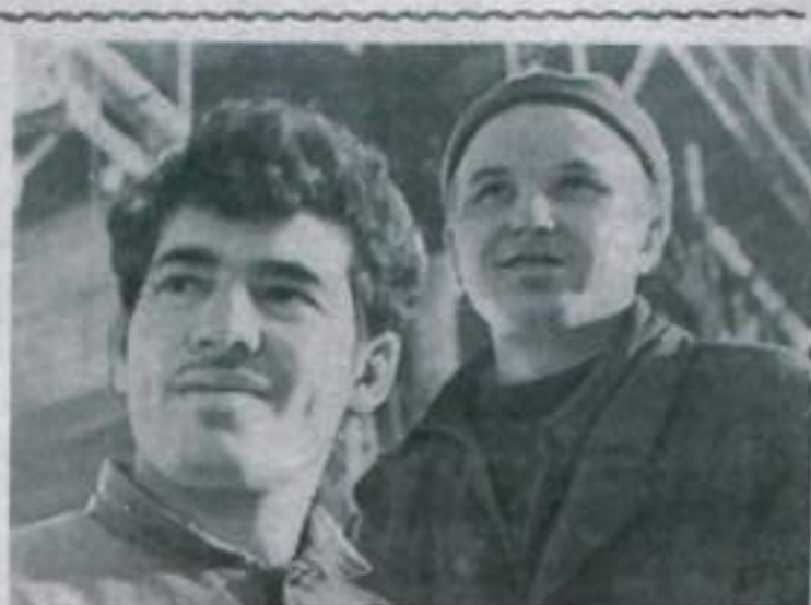
Азербайджанская ССР. На строительстве Али-Баба-Ярской ГРЭС—одной из первых электростанций открытого типа—широта фронт работ. Конец 1962 года строители ознаменовали вводом в строй второго энергоблока. В текущем году они должны сдать в эксплуатацию еще две турбины мощностью по 150 тысяч киловатт. В сооружении ГРЭС участвуют посланцы многих районов страны. На снимке: передовые строители бригады монтажников Виктор Лойко (справа) и Слесарь из его бригады Рамиз Керимов. Фото С. Кудашова. Фотохроника ТАСС.
