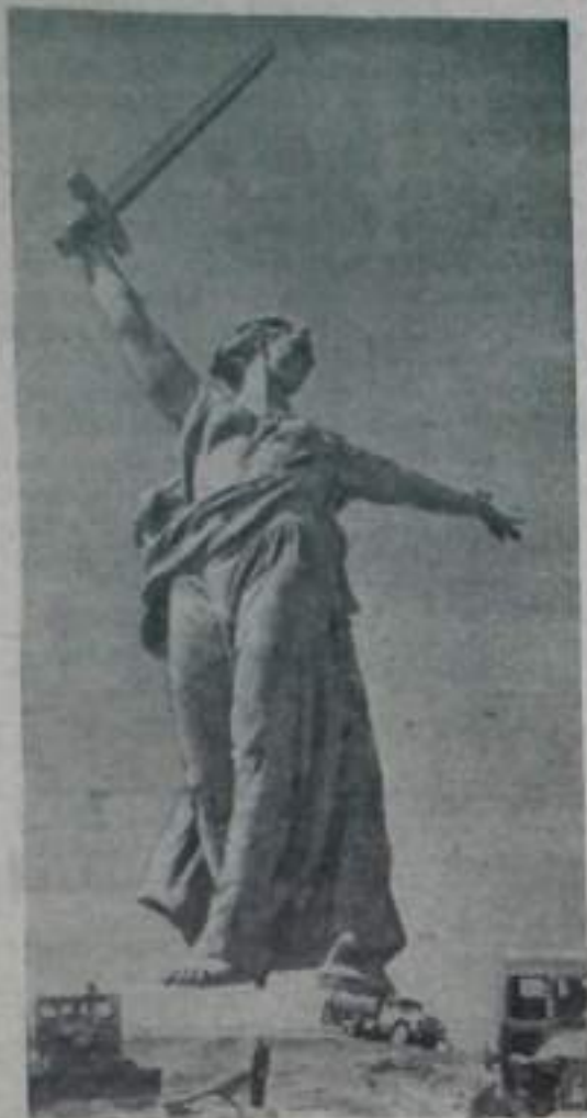
ВОЛГОГРАД. Закончена работа над главной скульптурой монументального панно «Герои Сталинградской битвы». Это — фигура женщины с поднятым вверх мечом, символически Родина-мать. Высота фигуры более 80 метров, а вес свыше 3 тысяч тонн. Скульптура выполнена из железобетона и установлена на самой вершине Мамаева кургана. Сооружение грандиозного панно осуществляется по проекту большой группы авторов под руководством народного художника СССР К. Вучетича. Вся скульптурная композиция будет закончена к концу 50-летия Советской власти.
