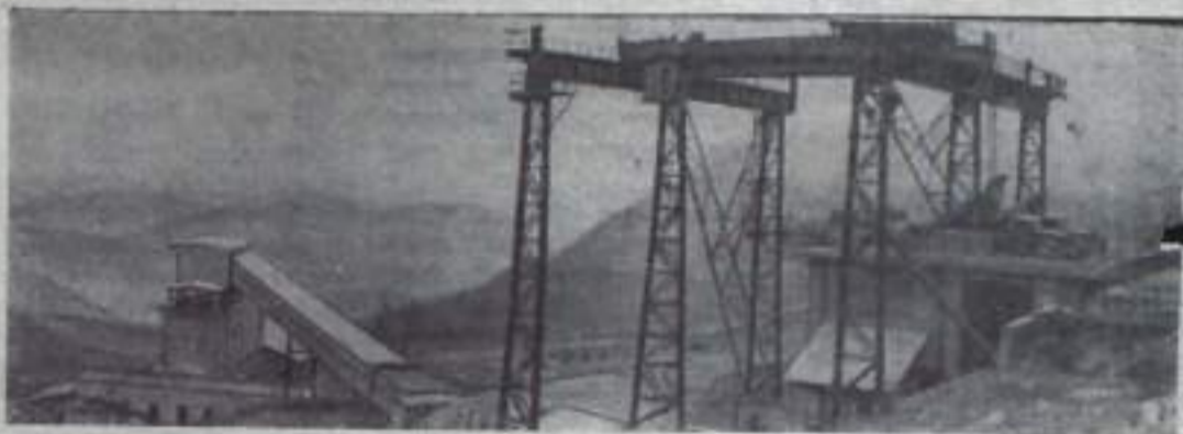
АЗЕРБАЙДЖАНСКАЯ ССР. Началась разработка Заглинского месторождения алюминия, которое относится к числу крупнейших. С высоты двух тысяч метров минерал доставляется на железнодорожную станцию, а оттуда — на Кировобадский алюминиевый завод, где будет использован для получения гли-
