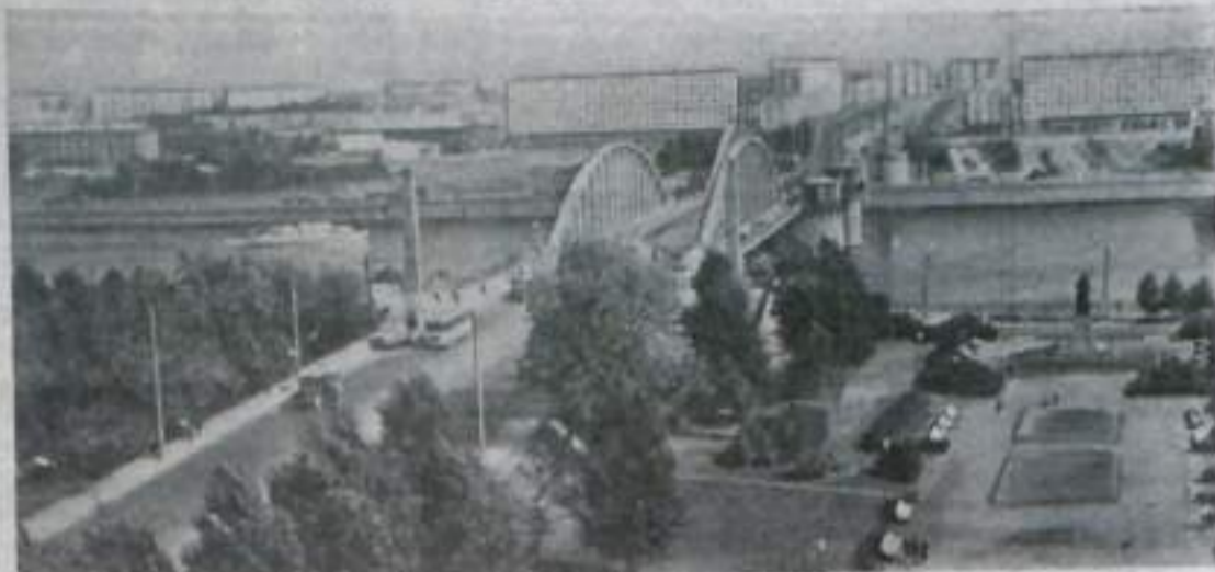
На снимках: новые жилые кварталы Невской заставы в районе Володарского моста.
