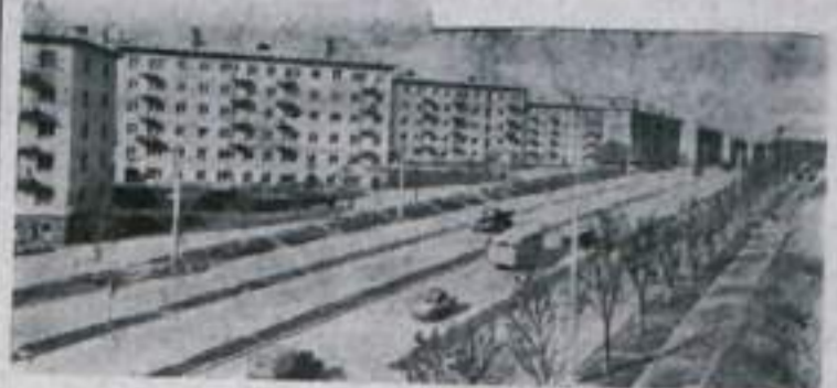
Во Владивостоке ведется большое жилищное строительство. Только за последние 3 года появилось десять новых районов. НА СНИМКЕ: проспект Столетия Владивостока в новом Северо-Западном районе города. Фото Н. Назарова.
