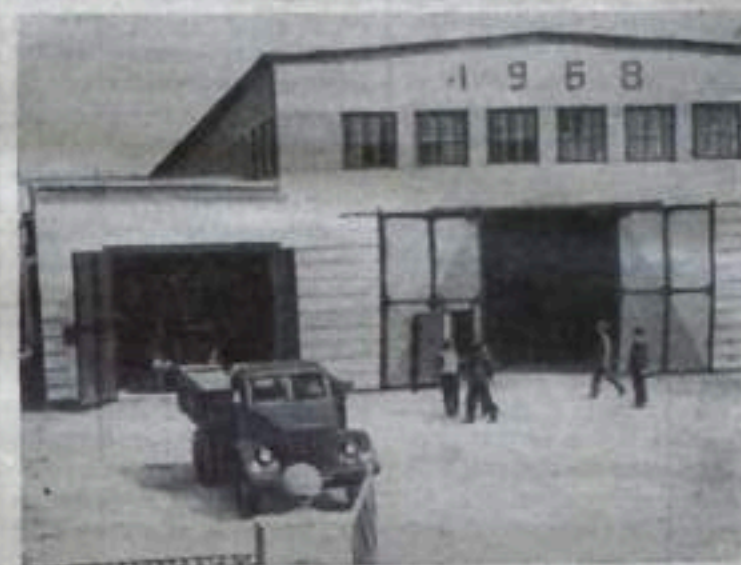
ХМЕЛЬНИЦКАЯ ОБЛАСТЬ Механизаторы и инженеры «Сельхозтехники» Волочисского района своими силами построили и до-срочно ввели в эксплуатацию станцию технического обслуживания колхозных автомобилей. На станции два цеха. В одном, где установлены конвейерные линии, осуществляется технический уход за автомобилями, в другой вид предназначен для заочного ремонта. За год станция сможет обслужить 500—550 автомобилей. К строительству таких станций приступили и другие районы.
