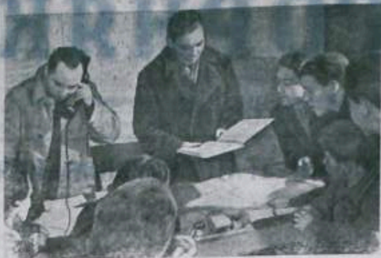
ЭСТОНСКАЯ ССР. Усилено идут работы на строительстве Прибалтийской ГРЭС — самой мощной в мире электростанции на сланце. Эта стройка — ударная комсомольская. В этом году будет досрочно пущен второй турбинный агрегат. Начальником работ является комсомолец из Ленинграда и Таллина. На стройке полным составом комсомольский штаб. Члены штаба своевременно сообщают и информируют на различные участки стройки. На заседаниях штаба обсуждаются вопросы устранения ошибок, мероприятия по развитию работы. Специальный штаб оказывает большую помощь руководству строительству. На снимке: очередное заседание комсомольского специального штаба Прибалтийской ГРЭС. В центре — начальник штаба, ударник коммунистического труда Н. Ковалев. Фото В. Горбунова. Фотохроника ТАСС.
