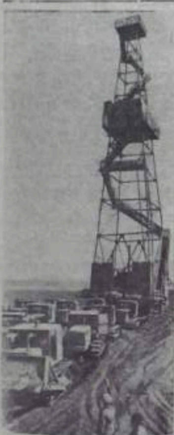
КРАСНОДАРСКИЙ КРАЙ. Бригада вышкомонтажников, руководимая И. И. Войтенко — передовая в нефтепромысловом управлении «Абиснефть». Она широко применяет взаимствованный у нефтяников других районов страны прогрессивный метод транспортировки буровых вышек с помощью нескольких тракторов без предкартельного демонтажа. За семь месяцев бригада И. И. Войтенко переместила таким способом 9 буровых вышек при плане 7. На снимке: транспортировка буровой вышки мощными тракторами. Фото И. Григорова. Фотохроника ТАСС.
