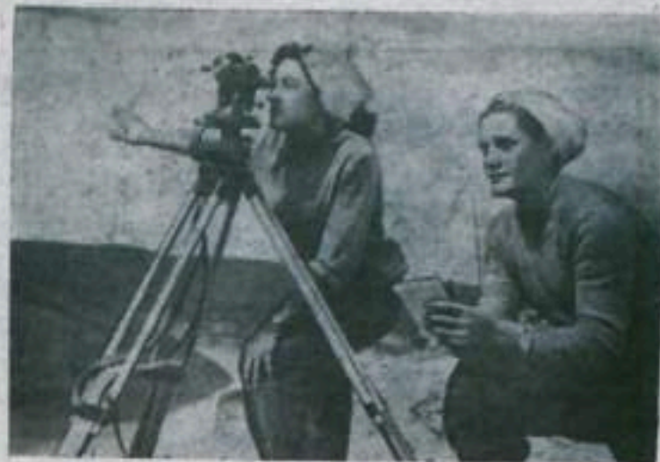
ВОСТОЧНО-КАЗАХСТАНСКАЯ ОБЛАСТЬ. На строительстве Бузтарминской гидроэлектростанции трудится много молодежи и девушек, приезавших сюда по комсомольским путевкам. С душой работают молодые патриоты.
