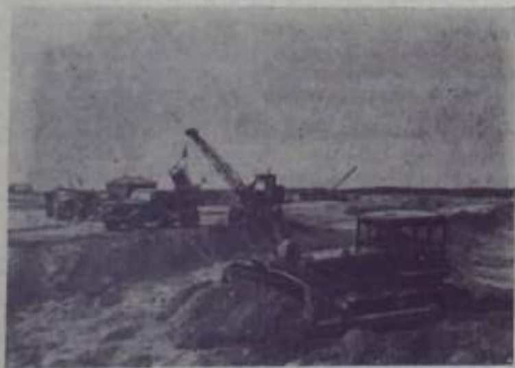
Калининская область. В Калининском районе сооружается одна из крупнейших в мире тепловая электростанция мощностью в 2.800.000 киловатт.
