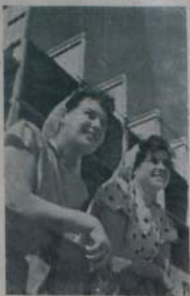
ЦЕЛИНОГРАД. Большую помощь оказывают ленинградцы строителям Целинограда. Бригада рабочих обкомского доместроительного колхоза №2 возглавляемая коммунистом Васильем Якушиным возводит в столице Целиного края многоквартирные жилые дома из крупноразмерных панелей. В этом году ленинградские монтажники сдадут для заселения четыре дома на 330 квартир.
