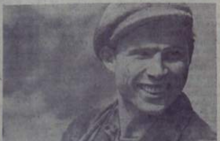
БЕЛГОРОДСКАЯ ОБЛАСТЬ. «Делать больше сегодня — это значит завтра иметь больше» — эти слова стали девизом коллектива земснаряда 507, работающего на вскрытии третьей очереди карьера Лебедянского рудника Курской магнитной аномалии. Хорошо трудится здесь ударник коммунистического труда электросварщик Сергей Дорощев. Он обеспечивает надежность работы всех механизмов, которые ему поручено контролировать. НА СНИМКЕ: Сергей Дорощев. Фото О. Сивова. Фотохроника ТАСС.
