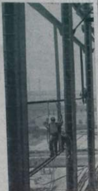
Оренбургская область. В Орске вступила в строй четвертая очередь ТЭЦ. Мощность станции увеличена на одну треть. Сейчас здесь сооружаются котлы высокого давления, где будут установлены дополнительные котлы высокого давления. Работы ведутся быстрыми темпами.
