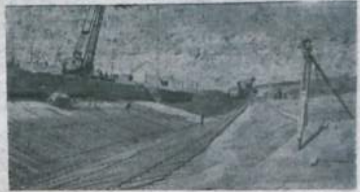
САРАТОВСКАЯ ОБЛАСТЬ. Десятки тысяч кубических метров бетона уложены в фундамент будущего здания Саратовской ГЭС. В настоящее время строители возводят железобетонные плиты водобоя, толщина их 2,5 метра.
