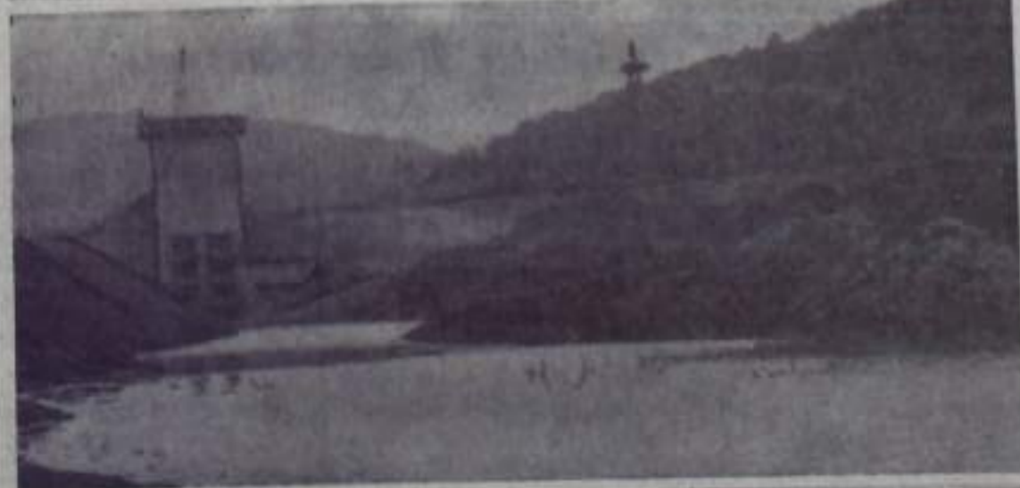
На этом снимке запечатлен поток реки по новому руслу. Вода устремляется к донному водоспуску гидростанции. Фото Ю. Ларина.
