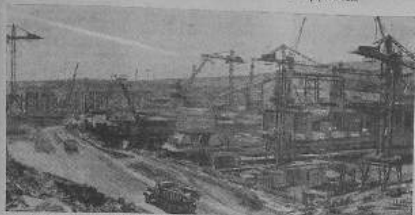
Днепропетровск. На строящемся Красном мосту. Препроборонит котельная, где свариваются трубы. Фото Ю. Барыш.
