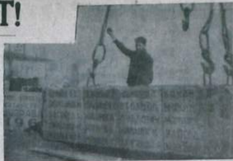
На снимке вы видите огромную железобетонную плиту, которая была доставлена к месту перекрытия реки. На ней написаны 20 фамилий труженников, отличившихся на строительстве Нугушского водохранилища. Эта плита погружена на дно русла реки. Она увековечила имена лучших гидростроителей. Фото В. Бушуева.
