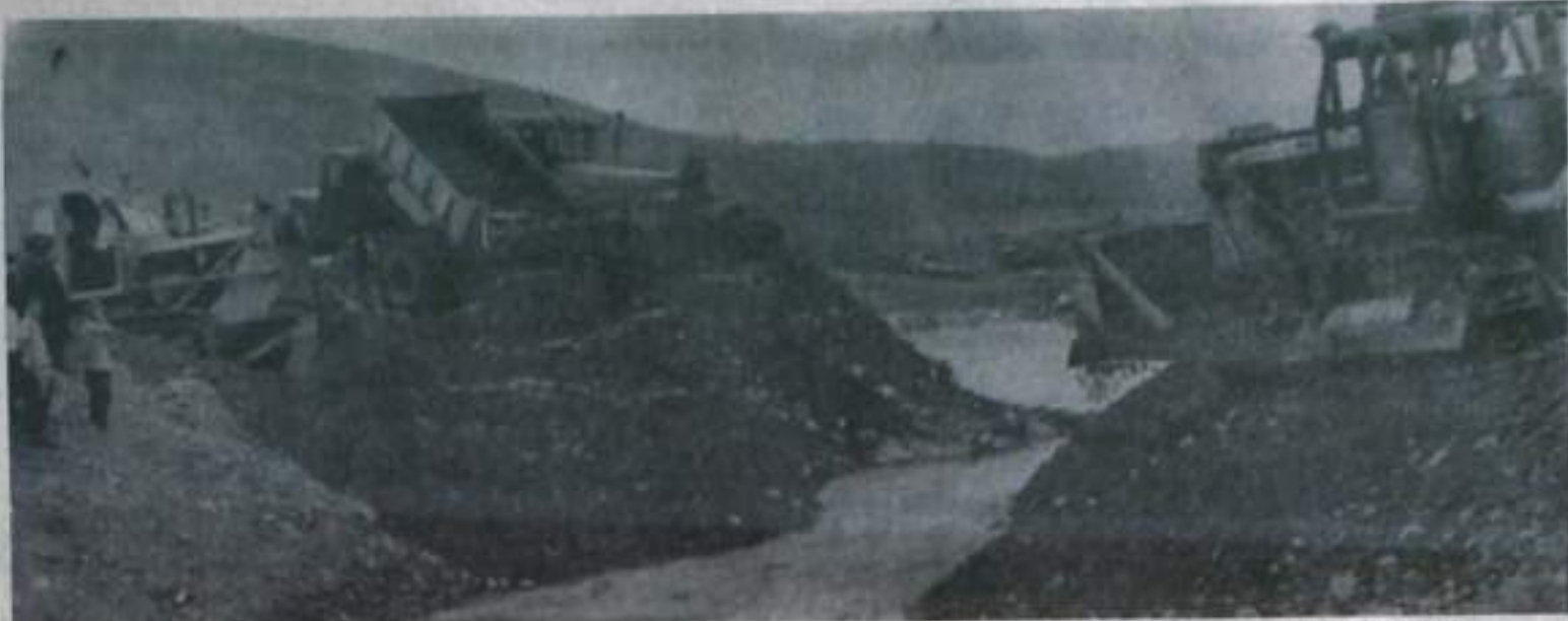
На снимке: решающие минуты. Мощные бульдозеры заканчивают перекрытие реки.
