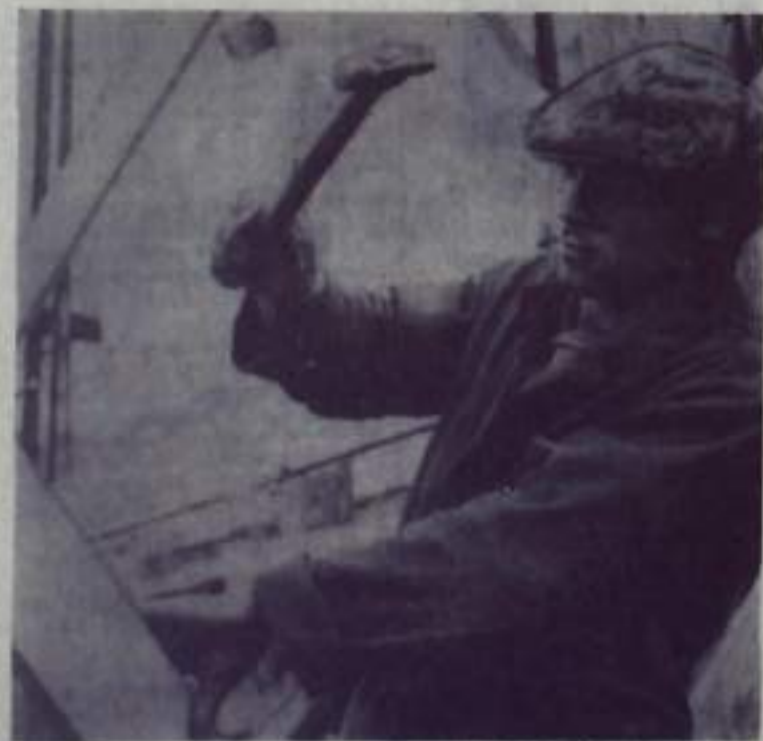
Гафур Маликов, который замечателен на этом снимке, работает в СУ-2, в строительной бригаде В. П. Пивоварова, плотником. Он владеет еще несколькими смежными специальностями — каменщиком, арматурщиком, стропальщиком, бетонщиком. И любую работу выполняет одинаково квалифицированно и добросовестно. Послужной список Гафура невелик. Окончил Стерлитамакское строительное училище, работал в СУ-2, затем был призван в Советскую Армию, а отслужив срок, снова вернулся в бригаду, где его приняли тепло и радушно.
