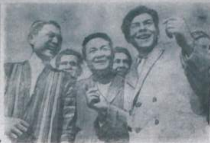
Узбекская ССР. Бригада арматурщиков Петра Иванцова Термезского ИБС строительного управления одержала большую трудовую победу в 1960 году. Она выполнила два годовых плана. На дикх ей присвоено звание коллектива коммунистического труда.
