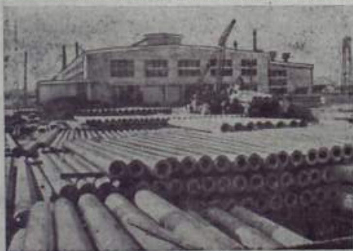
Демократическая Республика Вьетнам. В пригороде Ханоя построен завод железобетонных изделий. Он выпускает трубы, столбы для электротранспорта и другие изделия, всего более семидесяти наименований.
