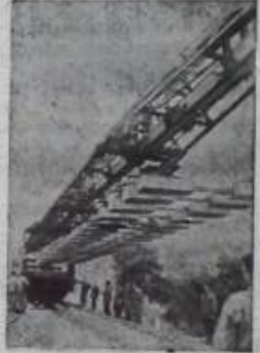
Чехословацкая Социалистическая Республика. На ремонте железнодорожных путей в ЧССР широко используется советская техника. Сроки ремонта при этом значительно сокращаются. На снимке: кран советского производства для укладки рельсов. Фото ЧТК — ТАСС.
