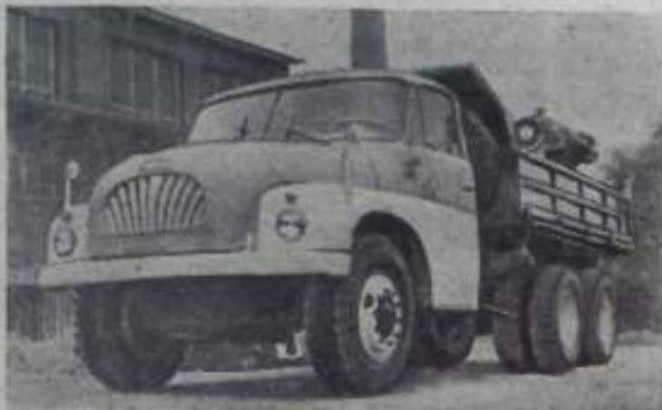
Чехословацкая Социалистическая Республика. Новейший тип автомобиля «Татра-138». Он предназначен для перевозок грузов до 12 тонн. У него, как и у других грузовиков «Татра», воздушная система охлаждения, благодаря которой автомобили этой марки в настоящее время не имеют себе равных в работе при особо тяжелых эксплуатационных условиях — в тропической гористой местности и в заполярье. ЦТА—ТАСС
