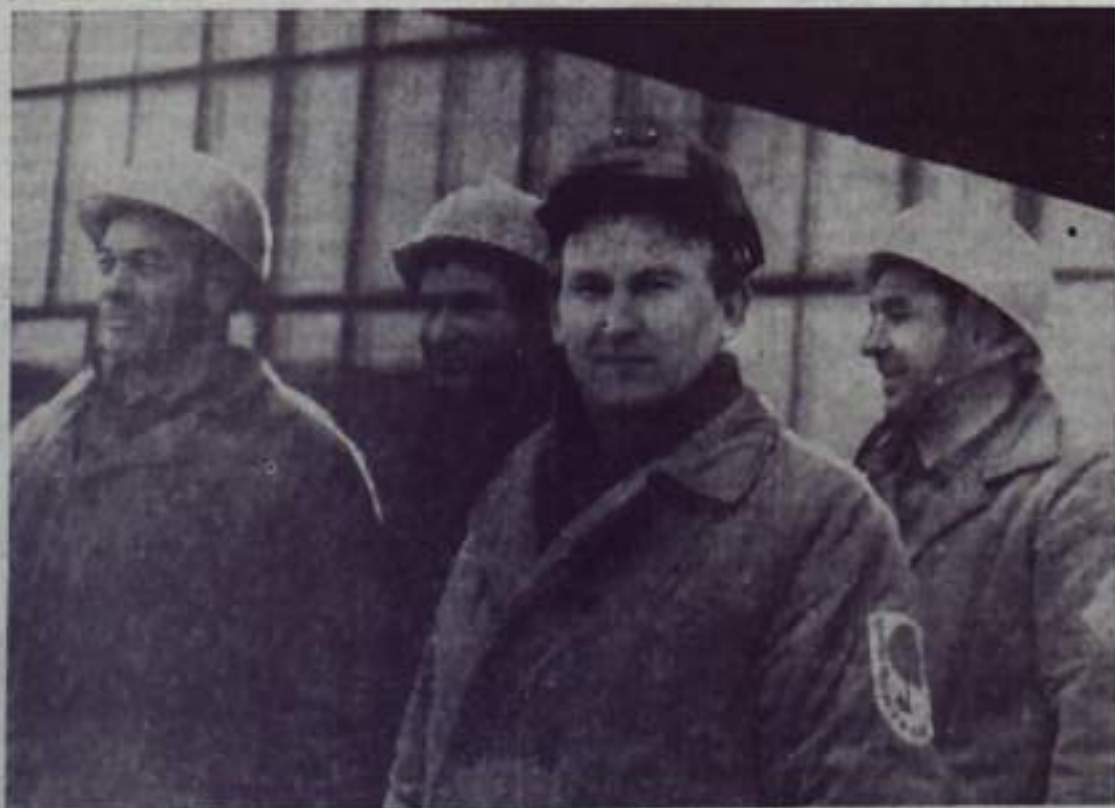
Бригадир Салаватского монтажного управления № 2 «Восточный» (справа) закончил монтаж прессов и маслонасосов на СПК-Б.
