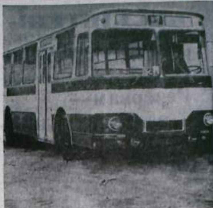
Недавно на городских маршрутах появились новые автобусы марки ЛИАЗ-677, партия которых прибыла в автоколону № 1832 с Ликинского автозавода. Конструкторы машины предусмотрели максимум удобства для пассажиров: широкие двери, обогреваемый салон на пневматической подушке, который вмещает более 100 человек. Созданы удобства и для водителей — у автобуса автоматическое переключение передач.
