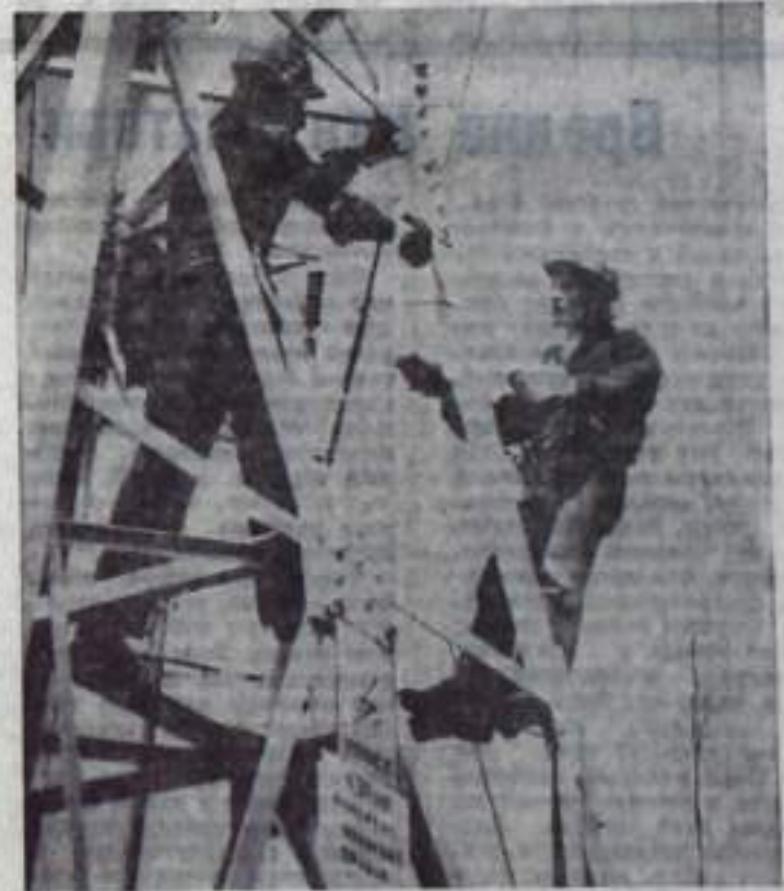
А. Галаутдинов и А. Гафаров — монтеры службы ЛЭП-35 и выше из бригады, возглавляемой Н. Р. Лопниным. Это их бригада вышла победительницей в республиканском конкурсе сетей и завоевала звание «Лучшая бригада «Башкирэнерго»».
