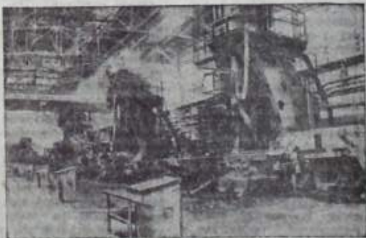
Кемеровская область. На Западно-Сибирском металлургическом заводе ширины 50 летия Октябрь вступил в строй комплекс среднесортного стана «450» мощностью 1.500.000 тонн проката в год. Стан сможет давать около 200 профилей проката. В ходе пуска валочных работ уже получено и отпущено потребителям свыше 30 тысяч тонн проката. На снимке: участок группы чистовых клетей среднесортного стана. Фото А. КУЗЬРИНА (Фотохроника ТАСС).
