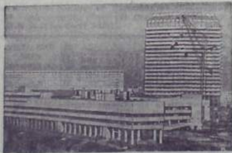
Москва. В завершающую стадию вступило строительство Онкологического научного центра, сооружаемого на средства, поступающие от Всесоюзного коммунистического субботника.
