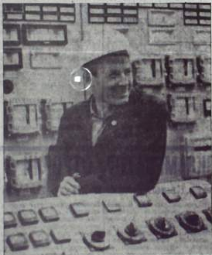
Тепловая электростанция. Отлично здесь трудится коллектив службы контрольно-измерительных приборов, возглавляемый старшим мастером, ударником пятилетки Петром Макаровичем Ульяновым.
