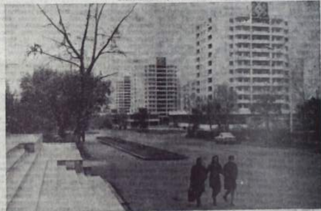
ГОРОД УФА. НОВОСТРОЙКИ В РАЙОНЕ УНИВЕРСИТЕТА.
