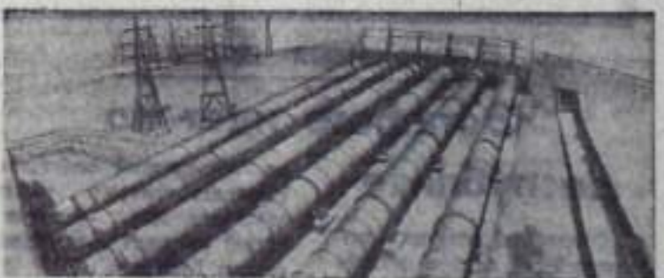
Убедительная ССР. В Каршинской степи ведется сооружение крупнейшего в республике Талимарджанского водохранилища, в котором будет накоплено 350 миллионов кубометров воды. Оно даст возможность до конца пятилетки освоить почти треть миллиона гектаров целины. Шесть насосных станций подают воду Амударью в Каршинский магистральный канал на высоту 130 метров.
